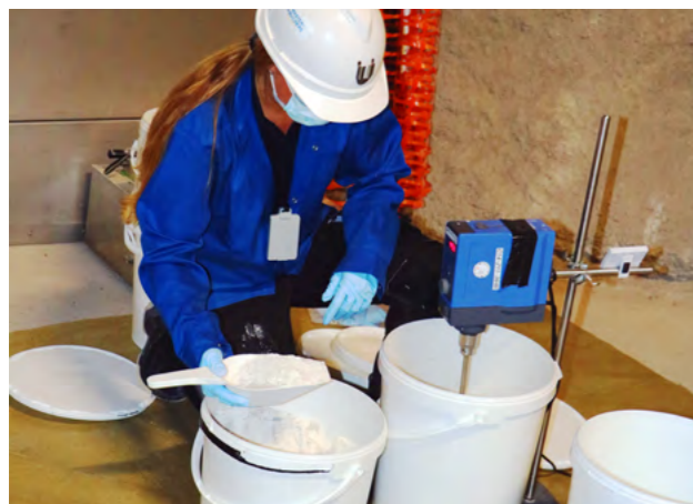
Mörtel wird im Felslabor Mont Terri für das Experiment angerührt.
