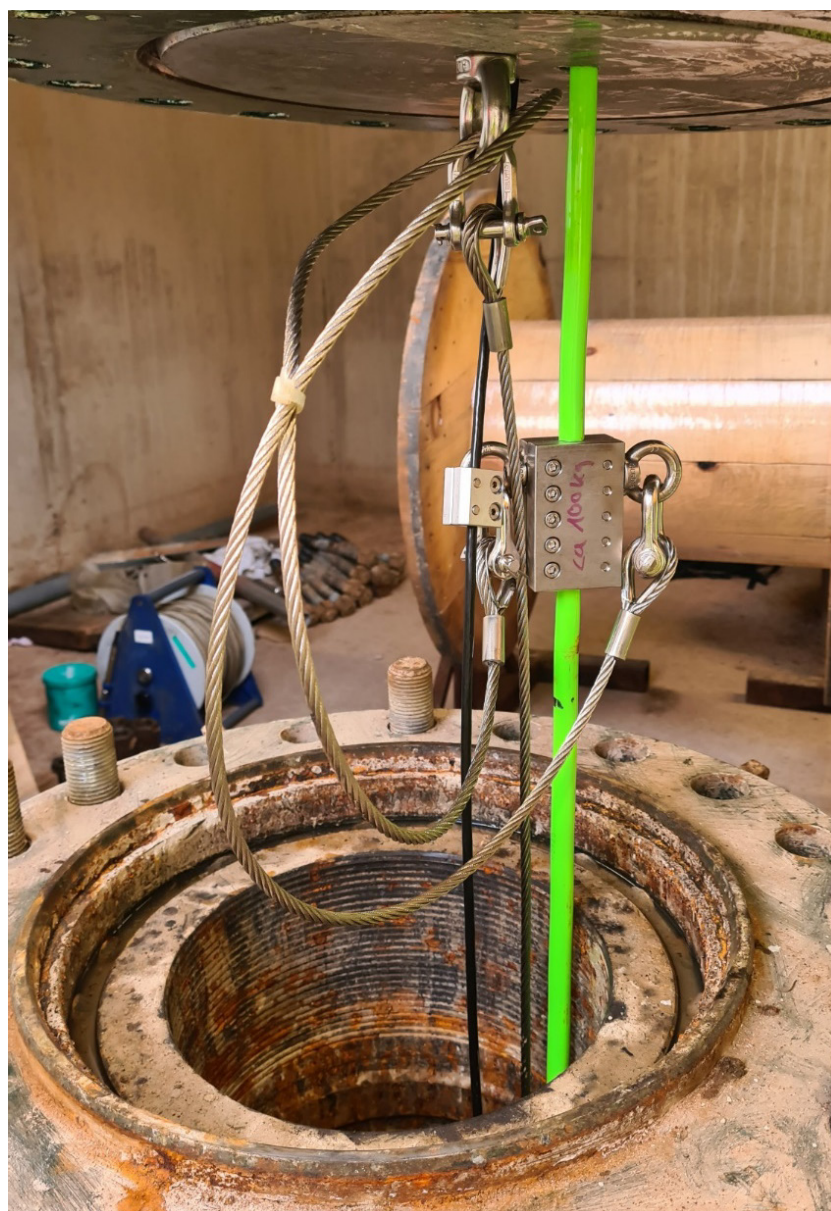
Fig. 3-16: Abfangen der beiden Kabel unterhalb des Flansches, 9:53 Uhr
