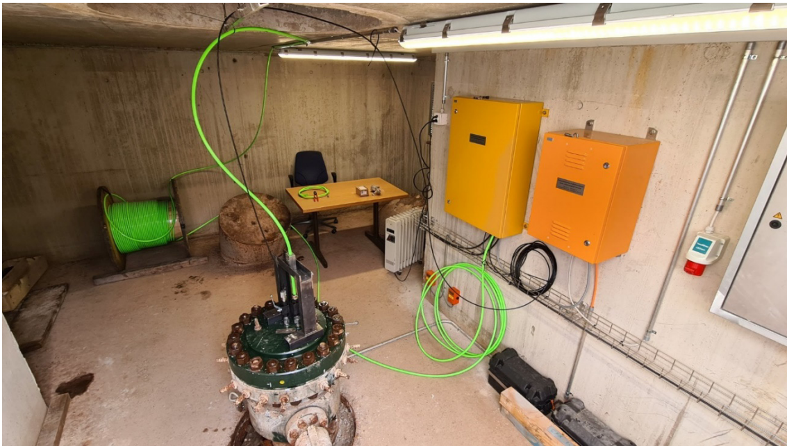
Fig. 3-17: Situation im Bohrkeller zum Abschluss der Arbeiten, 11:55 Uhr
