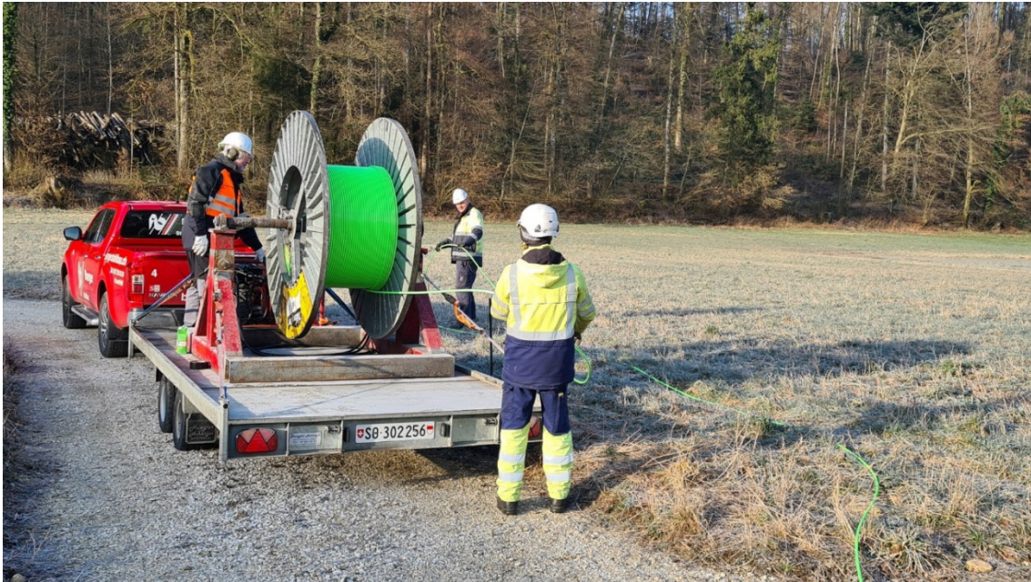
Fig. 3-13: Abspulen restliches Kabel auf dem Feld, 8:35 Uhr
