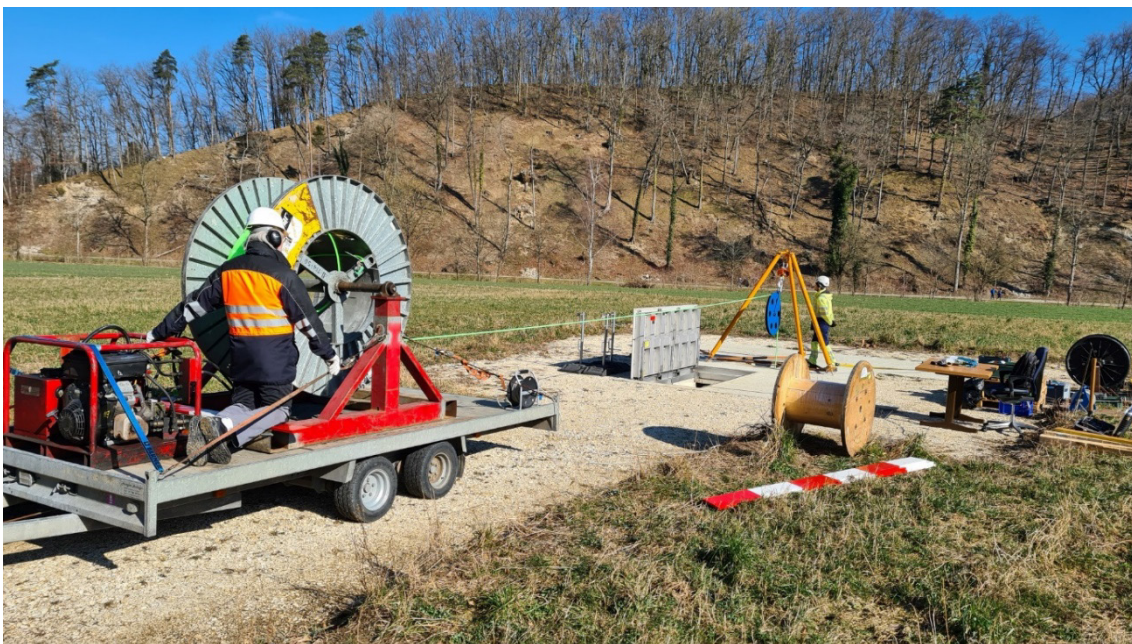
Fig. 3-10: Einfahren des Seismometers per angetriebener Kabelwinde, 10:51 Uhr
