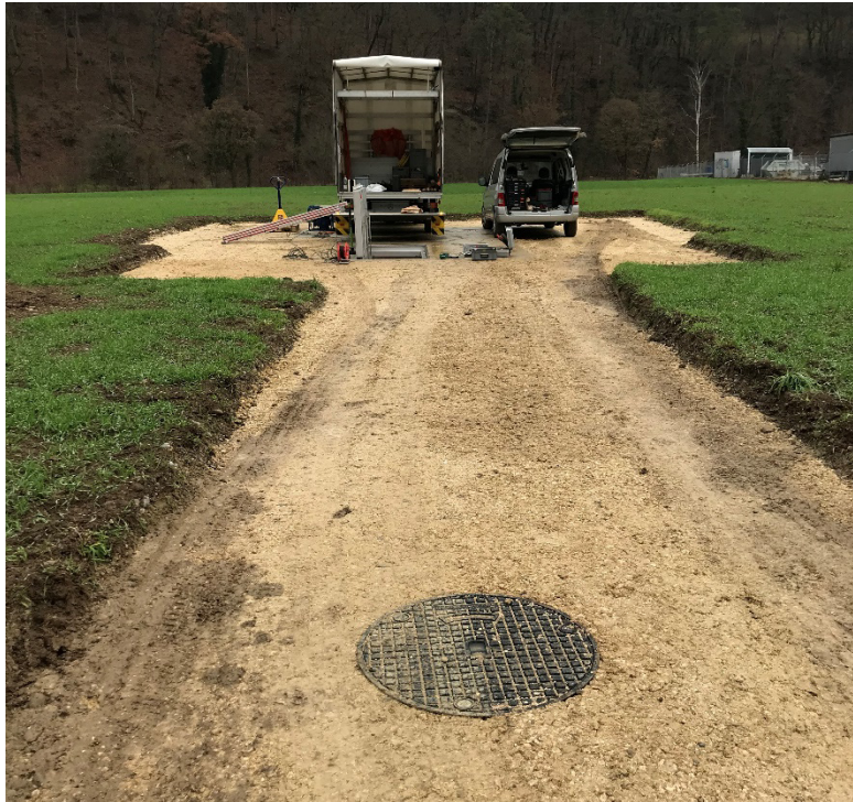
Fig. 2-3: Zufahrt zum Bohrkeller BUL1-1 und Installationsschacht für Oberflächensensor
