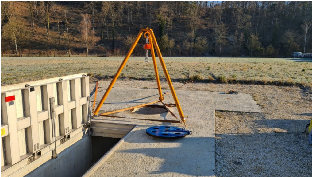
Fig. 3-5: 3-Bein ist aufgestellt und horizontal abgespannt (3. Abspannleine folgte später), 8:27 Uhr
