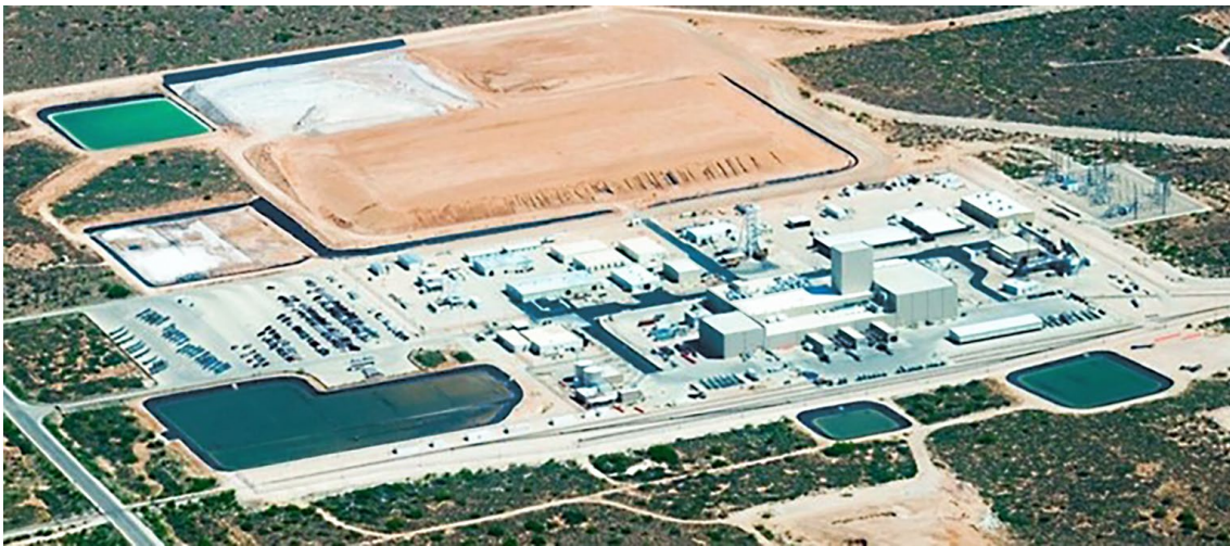
Fig. 6-7: Luftbild der Waste Isolation Pilot Plant (WIPP) in den USA
