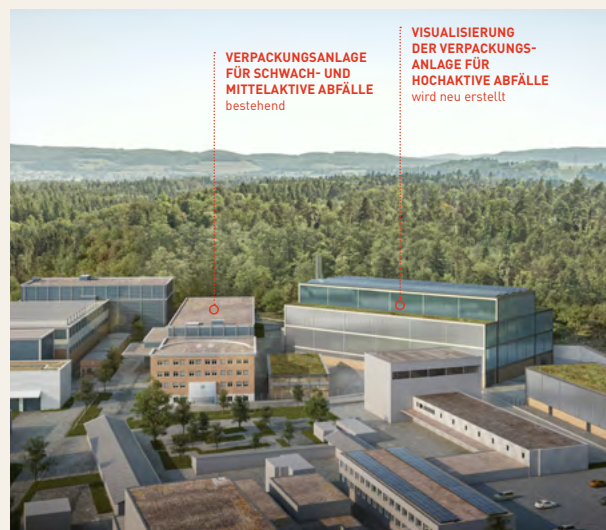
Die Verpackungsanlage beim Zwilag.
