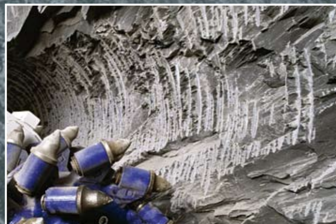
Im Herbst 2007 wurde mit der Erweiterung des Felslabors Mont Terri begonnen.
