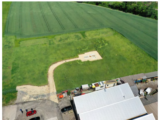
Der zurückgebaute Bohrplatz in Bülach.
