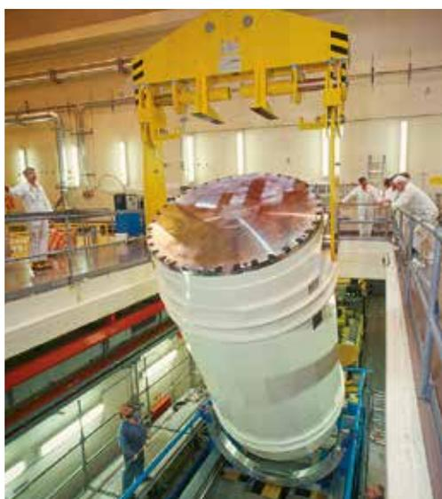
Vorbereiten eines beladenen Lagerbehälters zum Transport aus dem Kernkraftwerk Leibstadt ins ZWILAG (Foto: © Comet Photoshopping, Dieter Enz)
