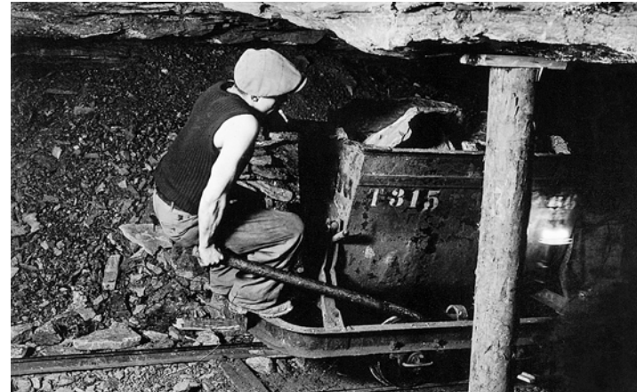
Lore (Kipptransporter auf Schienen), die im Bergwerk Käpfnach zum Transport der Kohle und des Schutts auf die Deponie gebraucht wurde. Auf der hintersten Lore eines Zugs fährt ein Bremser mit. Foto: Bergwerkverein Käpfnach (ZH)
