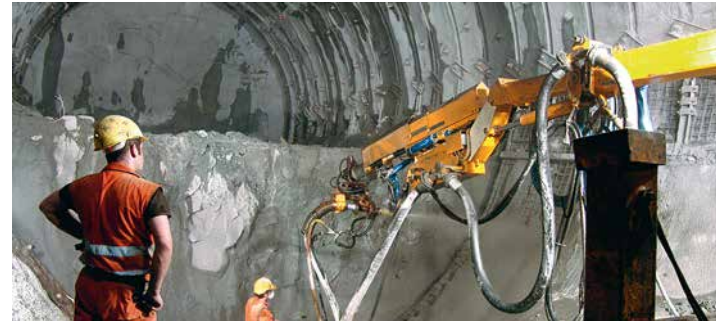
Ausbauarbeiten im Gotthard-Basistunnel. Foto: AlpTransit Gotthard, Luzern
