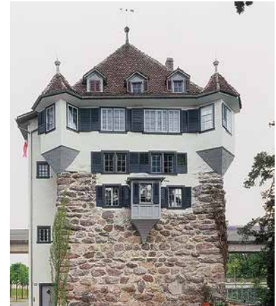
Hardturm. Foto: Kantonale Denkmalpflege Zürich, Dübendorf (ZH)
