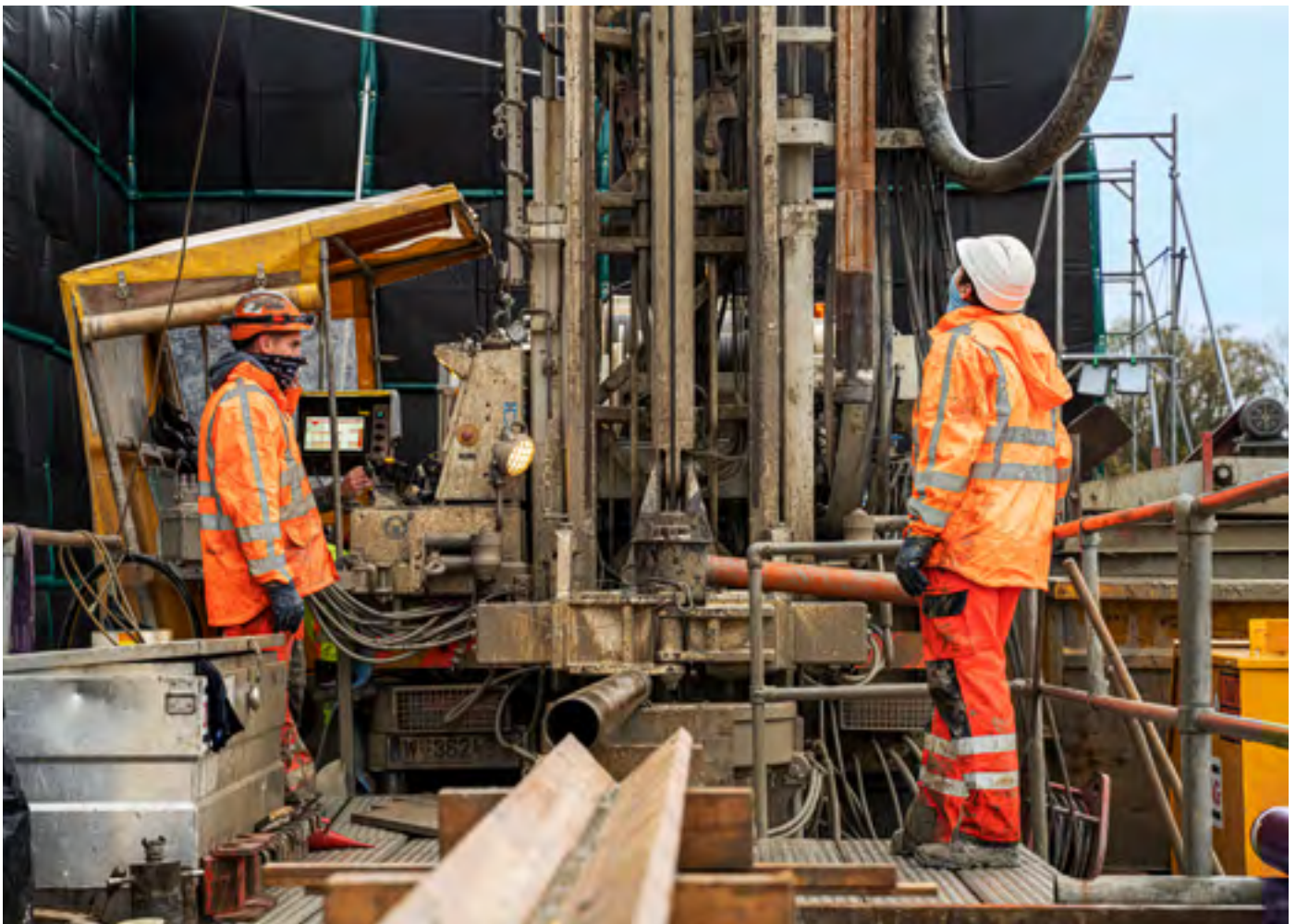
Oben: Der Bohrplatz der Quartärbohrung in Adlikon-Dätwil mit dem Bohrgerät. Die Wand schirmt die benachbarten Häuser vor dem Lärm ab. Unten: Die Bohrcrew zieht einen Bohrkern an die Erdoberfläche. Noch hängt er am Seil im Bohrloch.
