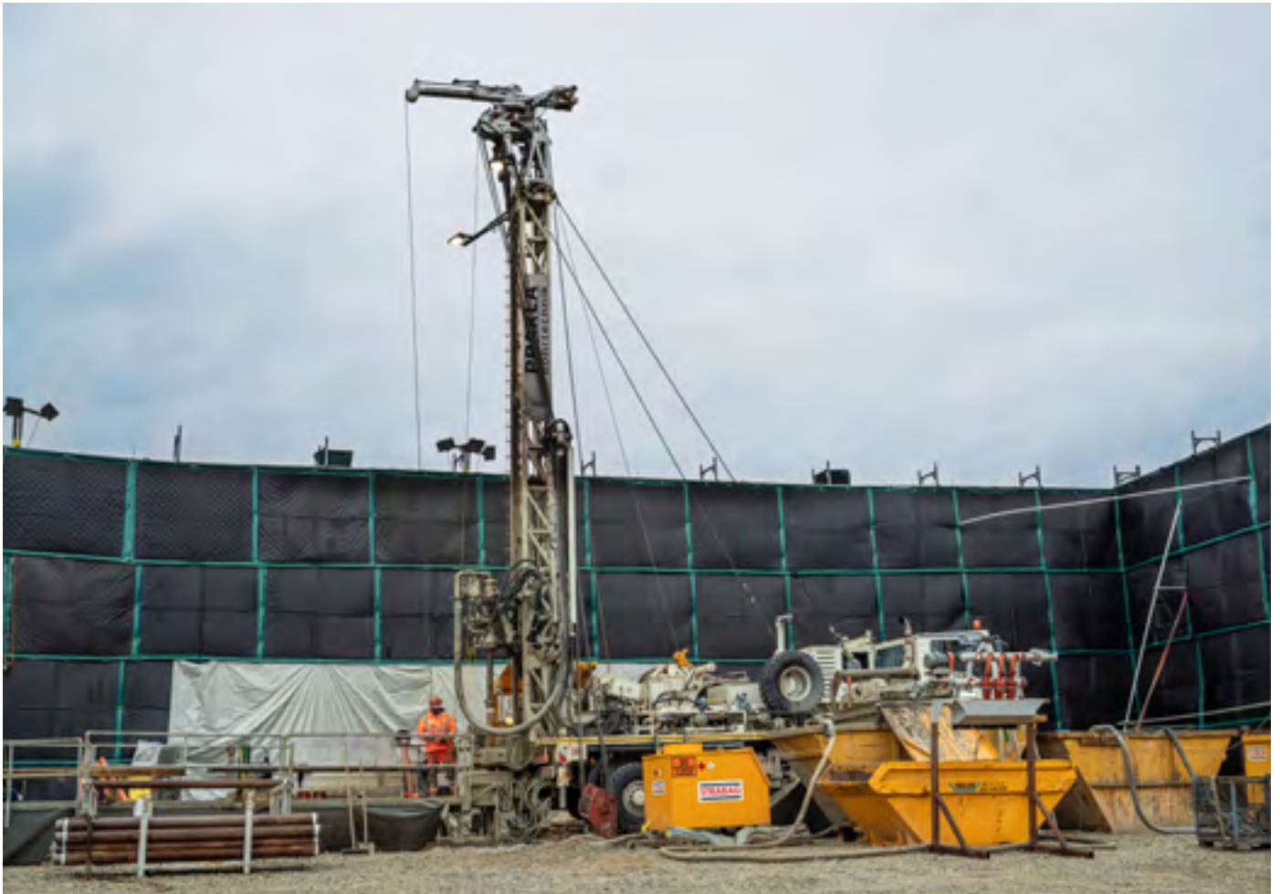
Oben: Der Bohrplatz der Quartärbohrung in Adlikon-Dätwil mit dem Bohrgerät. Die Wand schirmt die benachbarten Häuser vor dem Lärm ab. Unten: Die Bohrcrew zieht einen Bohrkern an die Erdoberfläche. Noch hängt er am Seil im Bohrloch.
