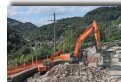
23. August: Baubeginn für neues Besucherzentrum im Felslabor Mont Terri
