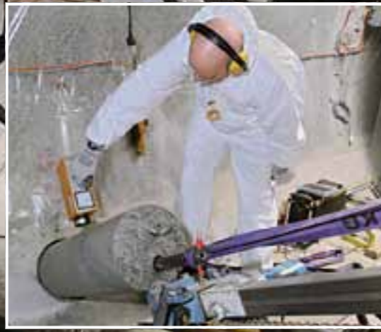
Gewinnung eines Überbohrkerns im Felslabor Grimsel (Experiment LTD).
